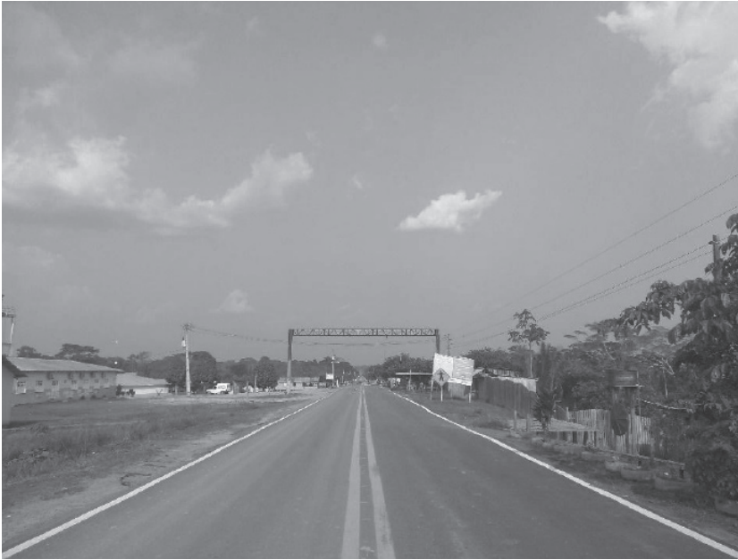
BR-364 localizada na Vila Maurício Mappes, sobre a ponte do rio Liberdade. À esquerda, pode ser observado um prédio azul, posto de saúde municipal.
